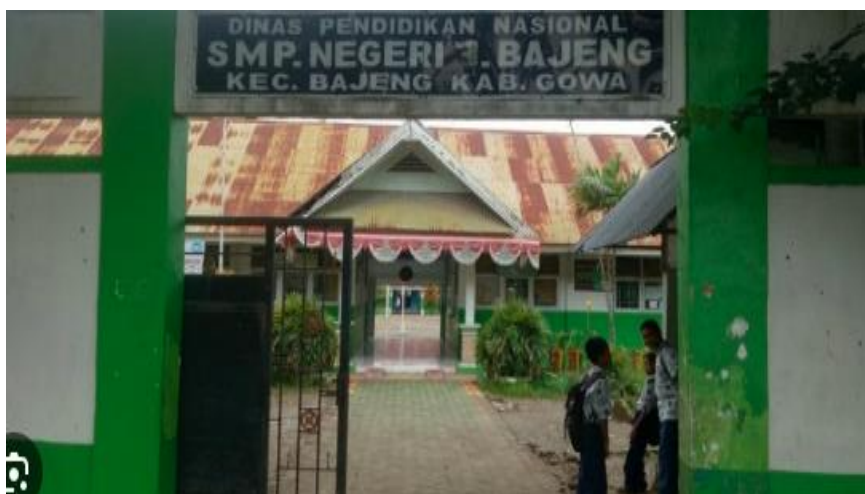
Gambar 1. Tampak depan SMP Negeri 4 Bajeng
